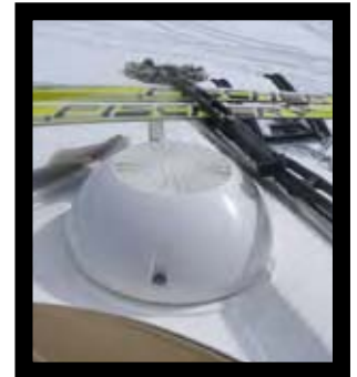
Lufting og takstativ
